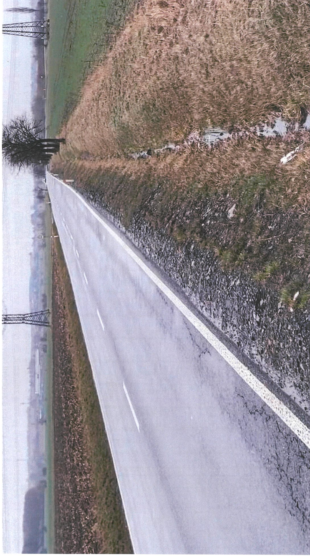
Obr. 8 - Pokračování úseku. Voda stojí v příkopu a souvislé poruchy vozovky. Tento stav vysvětluje podélný profil na dalším obrázku. Podélný spád je 0,85 % a po 50 m se snižuje na 0,27 %. Na tomto úseku byla provedena kopaná sonda KS 13 a vrtaná VS 14 dokumentující zavodnění celé vozovky až pod asfaltové vrstvy. Porušení úseku je dokumentováno v Příloze 2 ZP 8/2023 straně 11 až 14.
