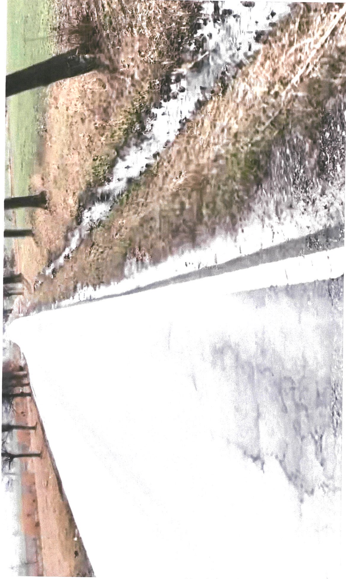
Obr. 5 - Podélný spád 1,42 %, pomalu odtékající voda a poruchy okraje vozovky
