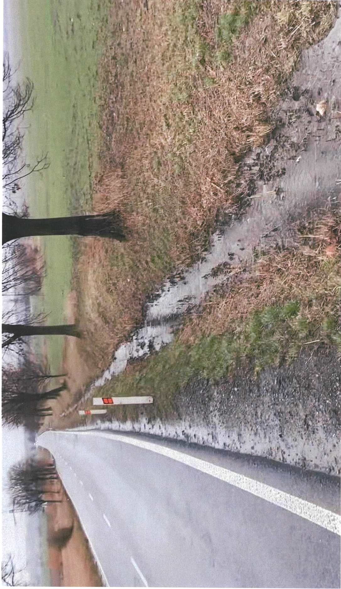
Obr. 4 - Současný stav: voda z rybníku skutečně teče příkopem, díky podélnému spádu 2,6 % je vozovka bez poruch, vzadu je spád je 1,42 % a jsou vidět poruchy
