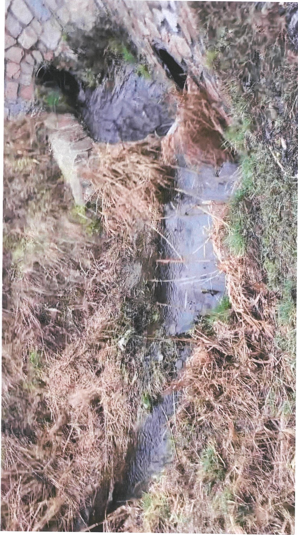
Obr. 7 - Detail prokazující, že bylo možno prohloubit příkop a odvést vodu snížením potrubí pod sjezdem na pole (viz. Obr. 6). Podélný spád 0,86 % je na délce 30 m, čili zvýšení spádu na 1,8% bylo možno tuto předešlou lagunu vyprázdnit do potoka. Vpravo nahoře je výtok z potrubí pod sjezdem na pole, vpravo dole je potrubí propustku v km 9,310, rozdíl výšek je větší než 30 cm. Vážný nedostatek jak v projektu, tak při realizaci
