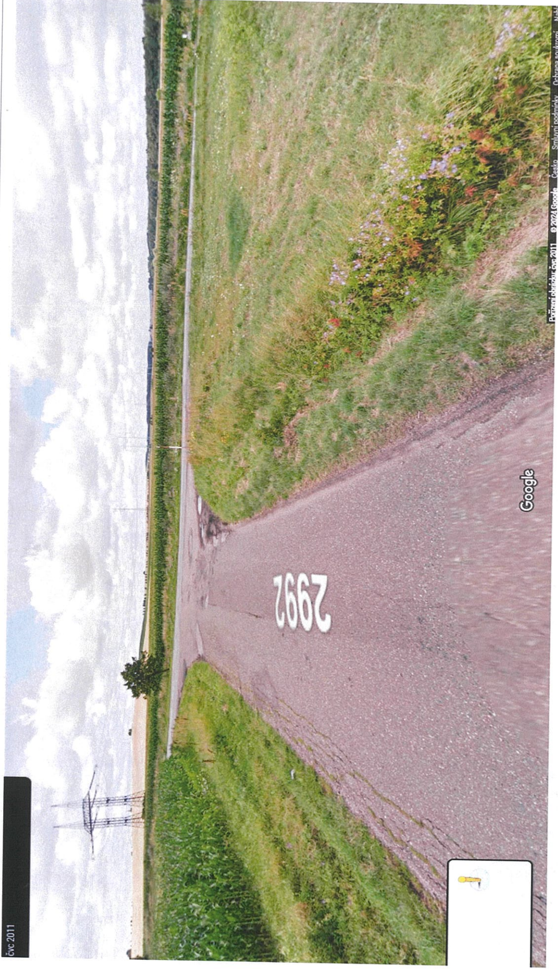
Obr. 13 - Pohled ze silnice ze směru od Výravy z roku 2011. Je vidět, že původní silnice za křižovatkou stoupá. Projektant tento „hrb“ v podélném směru silnice navrhl odstranit, ale propustek navrhnout nemusel, stačilo prohloubit příkop
