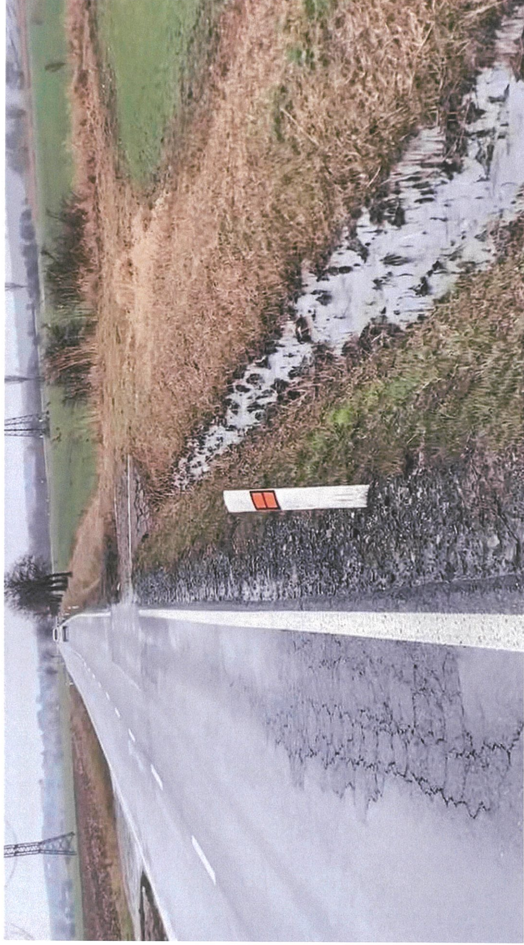
Obr. 6 - Pomalu odtékající voda a poruchy okraje vozovky před propustkem v km 9,31. Málo hluboký příkop, ten nemůže odvést vodu protékající v celé délce vozovky sanací podloží, a naopak zavodňuje vozovku a poruchy jsou úplnou ztrátou únosnosti vozovky díky zavodnění podloží vozovky. Podélný spád je pouze 0,86 %, ale bylo jej možno zvýšit, viz obr. 7
