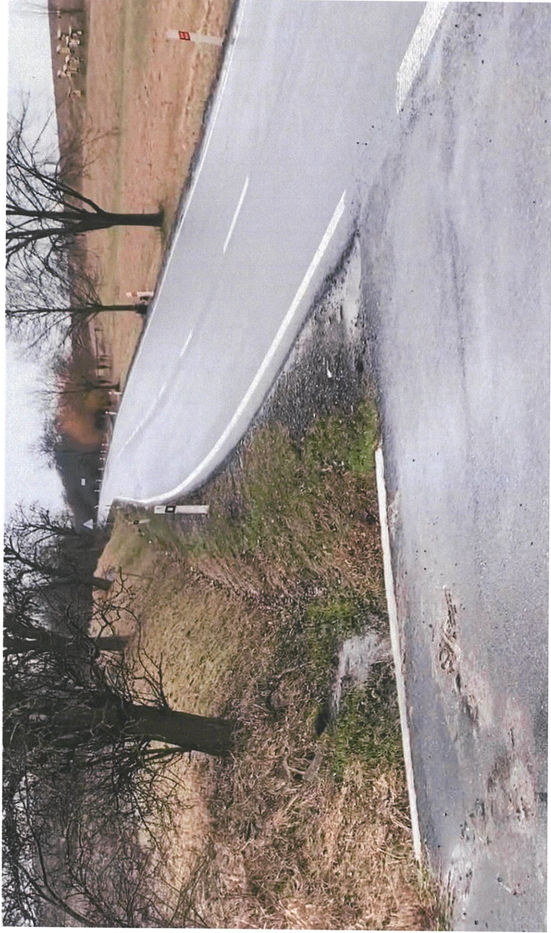
Obr. 3 - Současný stav v km 9,1 za deště, vyústění kanalizace odvodňující rybník. Vozovka je v podélném spádu 2,6 % a je bez poruch
