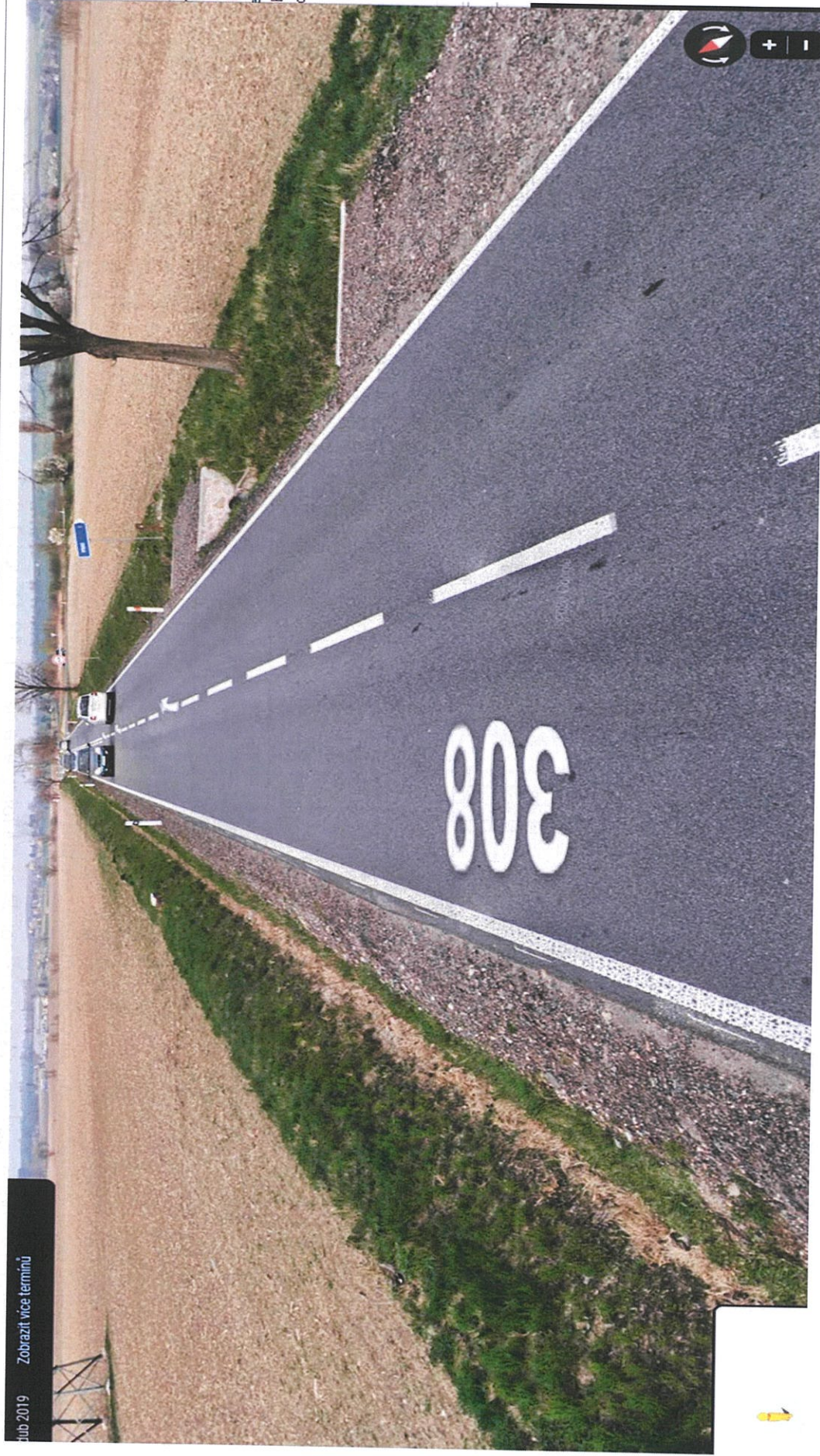
Obr. 11 - Vzadu před odbočením na Výravu je propustek v km 9,752. Délka příkopu od propustku 9,310 až do propustku 9,752 je 442 m a výškový rozdíl je 2,01 m. V levém příkopu je vrstva jílu, což může znamenat, že do příkopu přitéká také povrchová voda z pole nebo vody vytékající ze sanace podloží.
